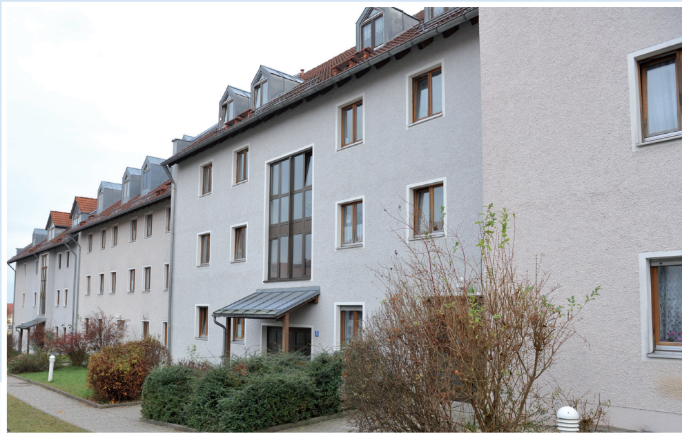
REINHARD-RAFFALT-STRASSE 8 - 18 UND SENEFELDERSTRASSE 1 + 3 79 WOHNUNGEN BAUJAHR 1993-1995
