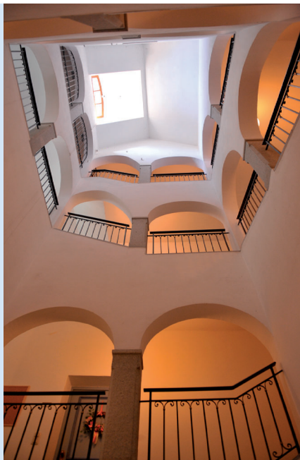
TREPPENHAUS KLEINE MESSERGASSE 1 6 WOHNUNGEN, SANIERUNG 1989
