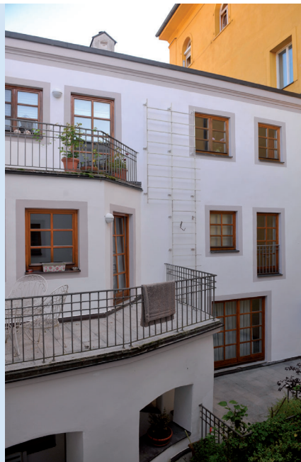
INNENHOF HÖLLGASSE 15 / PFAFFENGASSE 3 14 WOHNUNGEN, SANIERUNG 1992
