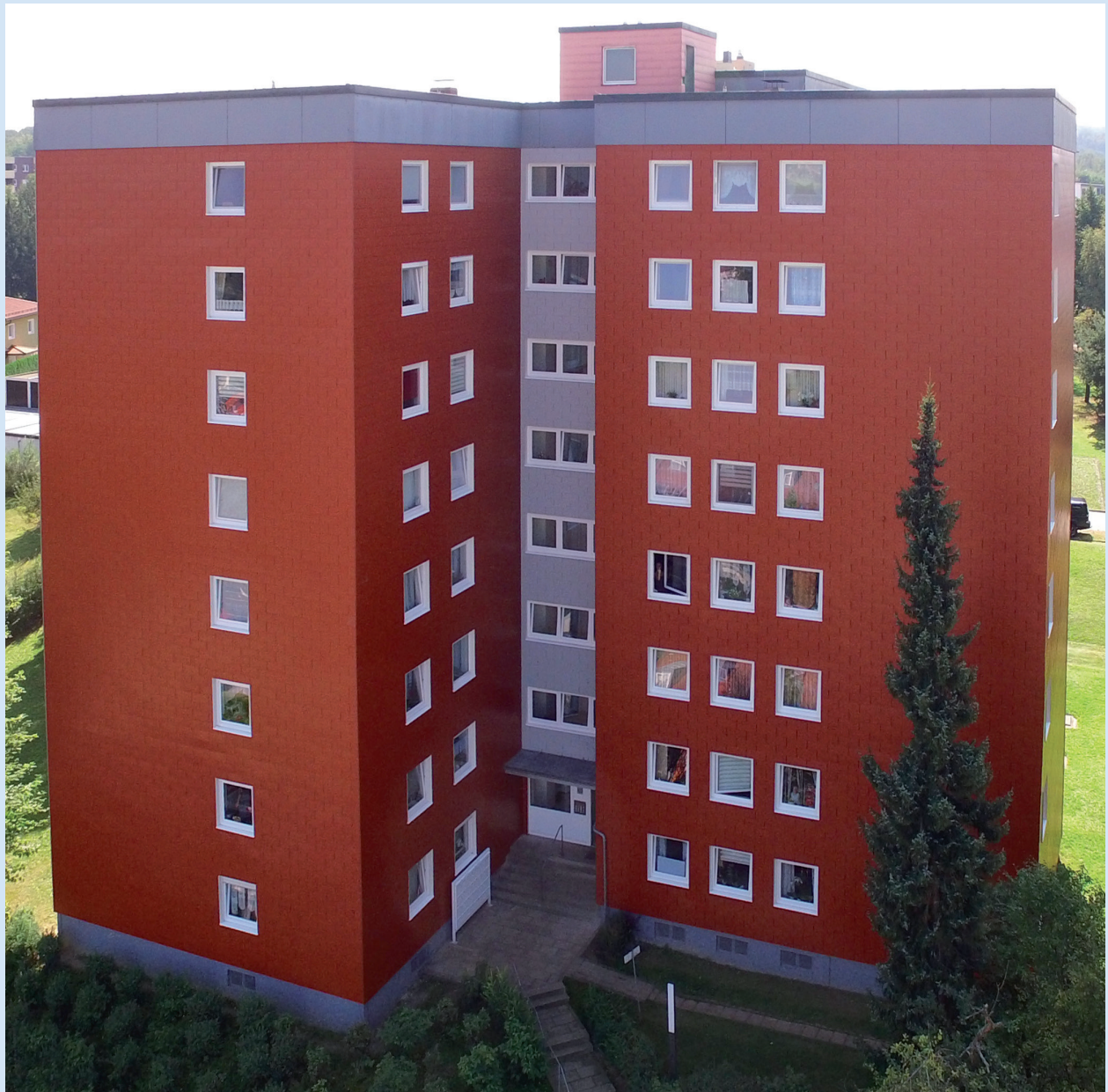
VORNHOLZSTRASSE 105, BAUJAHR 1971, 32 WOHNUNGEN
