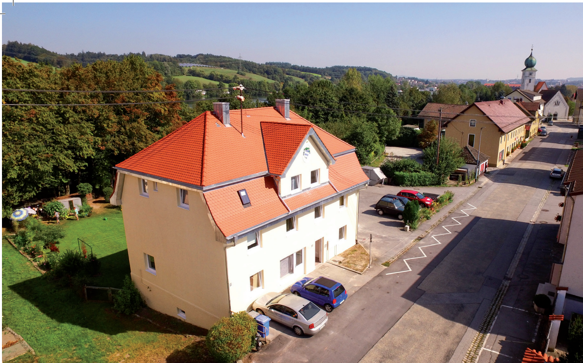
HEININGER STR. 32, BAUJAHR 1925, 5 WOHNUNGEN 1 GEWERBEEINHEIT
