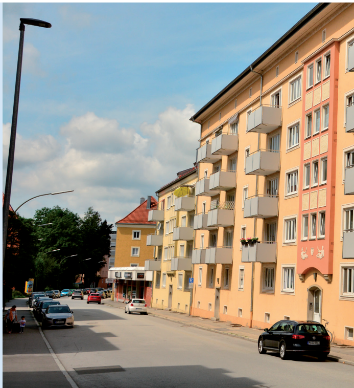
SPITALHOFSTR. 24-28, BAUJAHR 1955, 35 WOHNUNGEN NACH BALKONSANIERUNG
