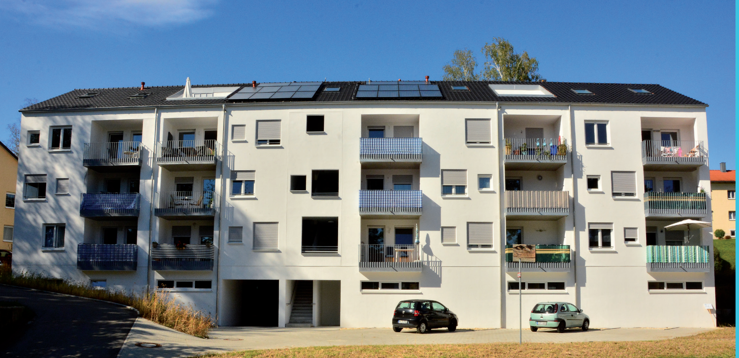
UNTERE SCHNECKENBERGSTR. 60 BAUJAHR 2019 17 WOHNUNGEN
