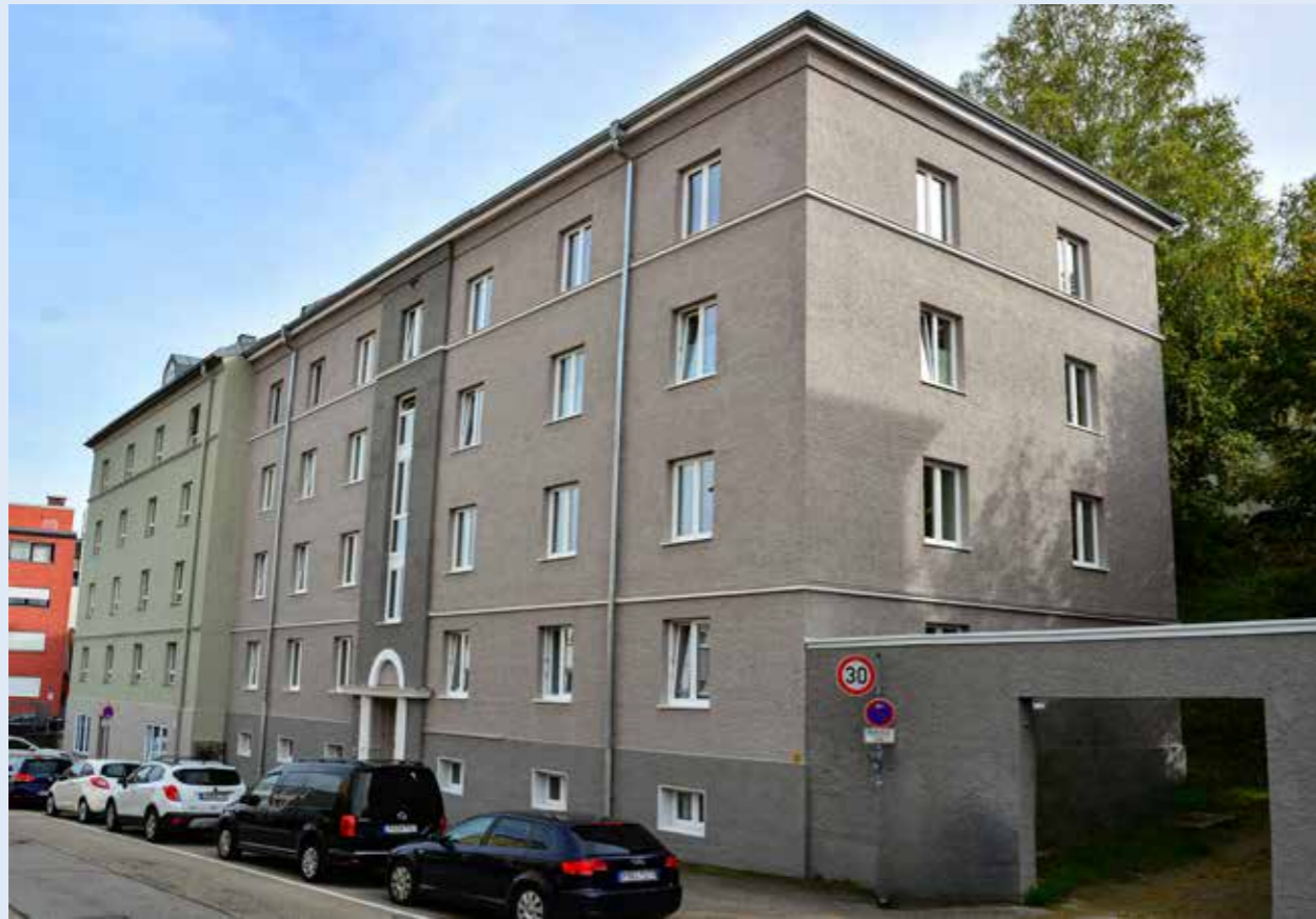
Schießstattweg 7 mit 8 Wohnungen nach der Fassadeninstandsetzung
