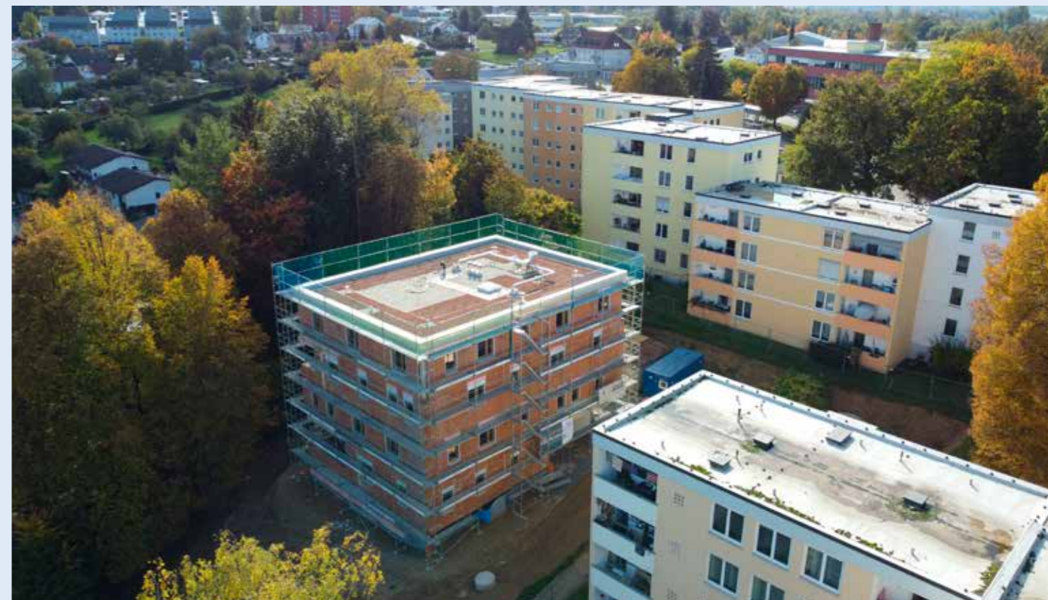
Bauvorhaben Vornholzstraße 63 mit 7 freifinanzierten Wohnungen
