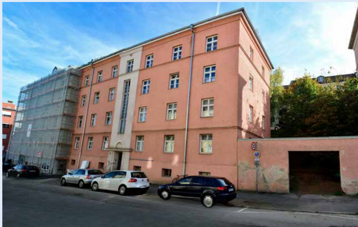
Schießstattweg 7 mit 8 Wohnungen vor der Fassadeninstandsetzung
